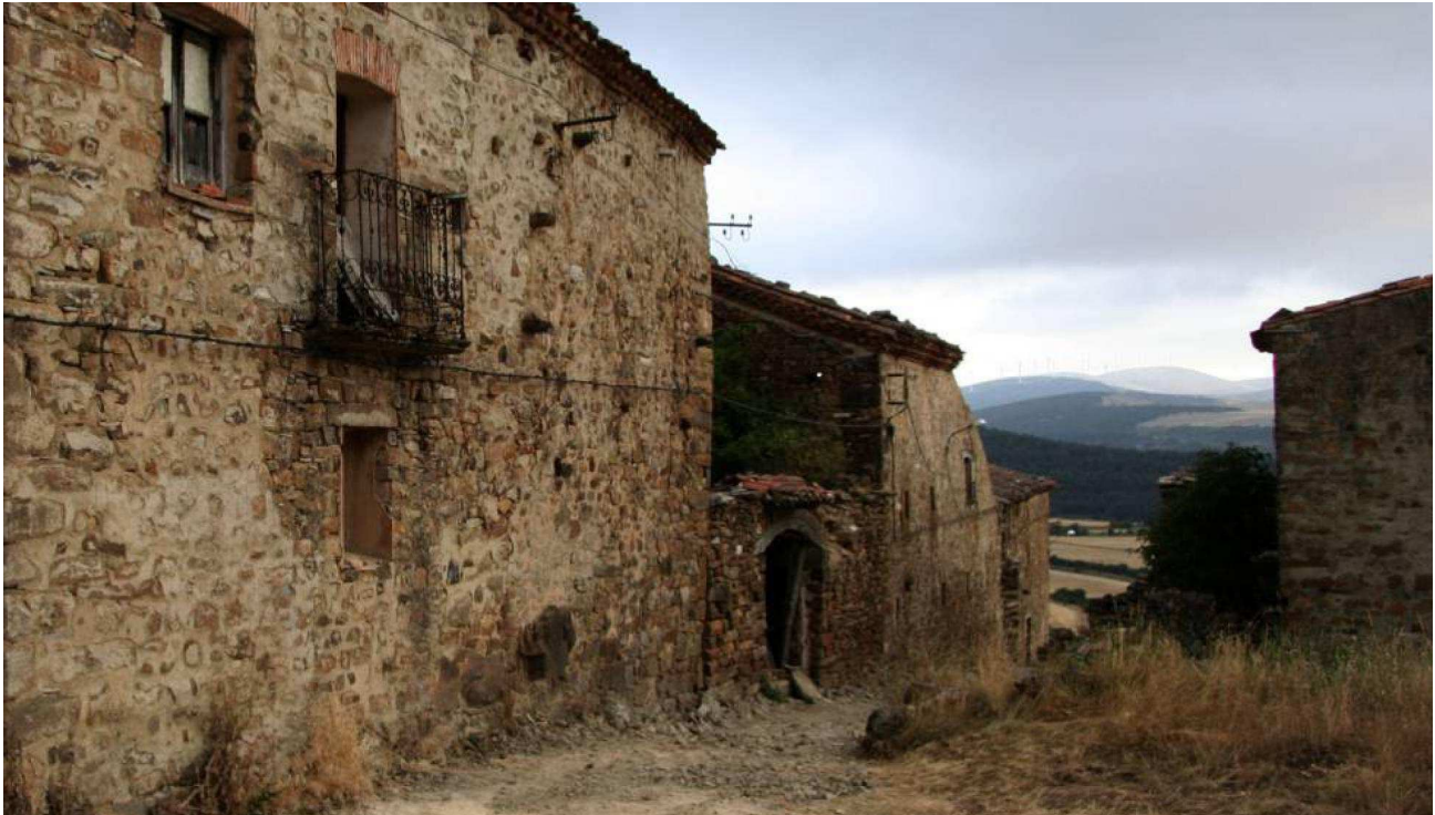
Sarnago, pueblo deshabitado de Soria en la sierra de Alcarama. BASILIO SAINZ
